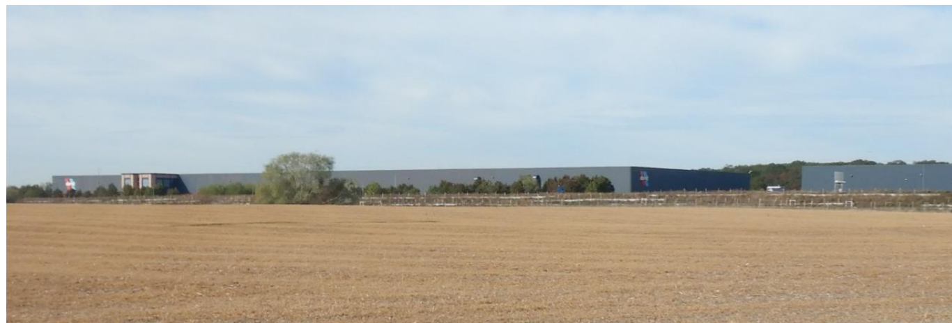
Photo 11 : entrepôts DERET Logistique depuis l'est de la zone du projet
