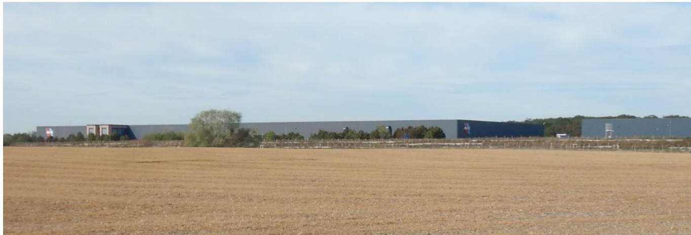
Photo 55 : entrepôts DERET Logistique depuis l'est de la zone du projet
