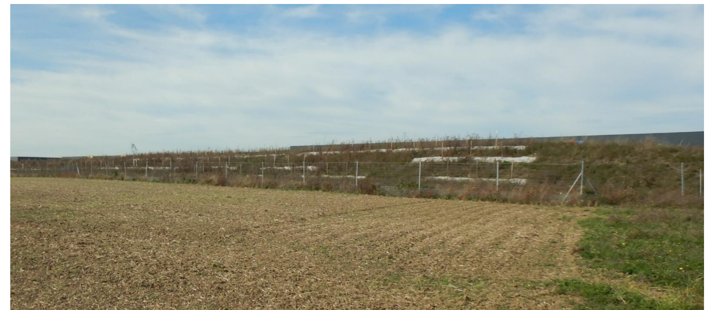
Photo 96 : talus autoroutier longeant l'autoroute A10 aux abords du projet
