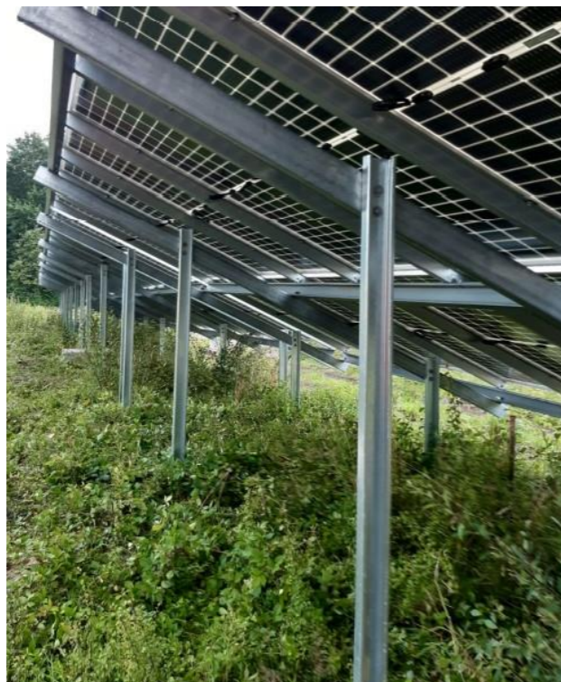
Photo 91 : fondation avec pieux acier
