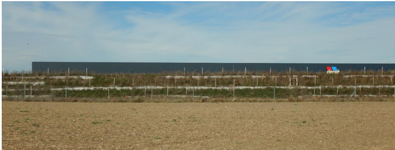
Photo 59 : talus le long de l'autoroute A10 en limite ouest de la zone d'implantation potentielle
