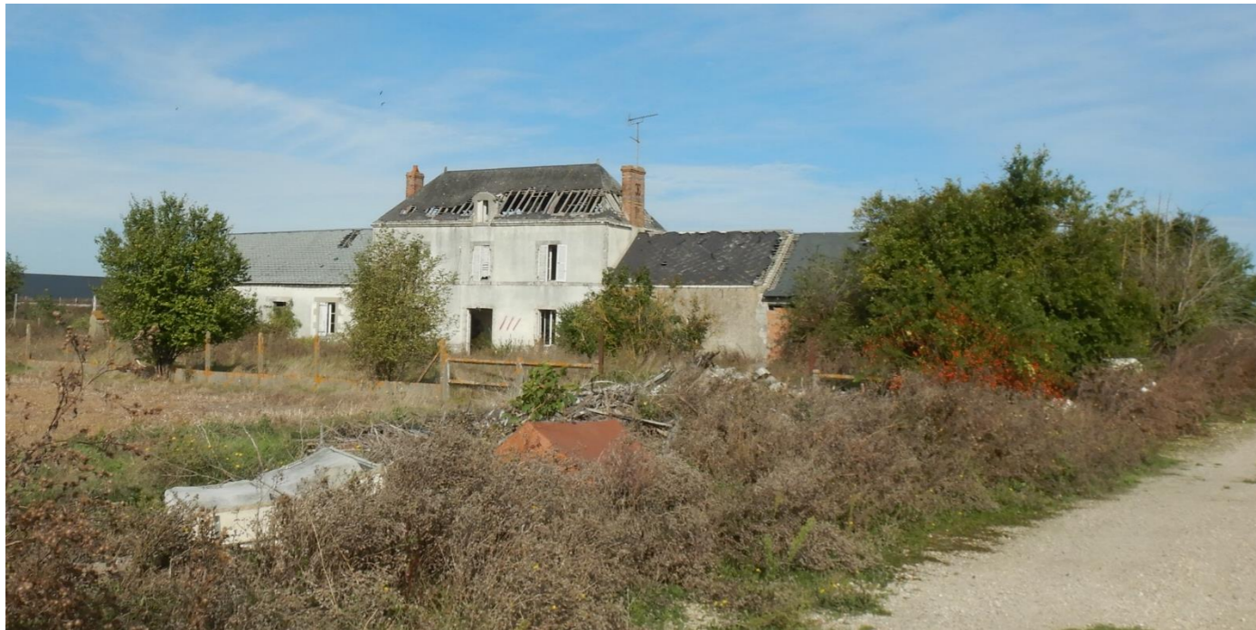
Photo 45 : ancienne ferme de l'Épineux en ruine
