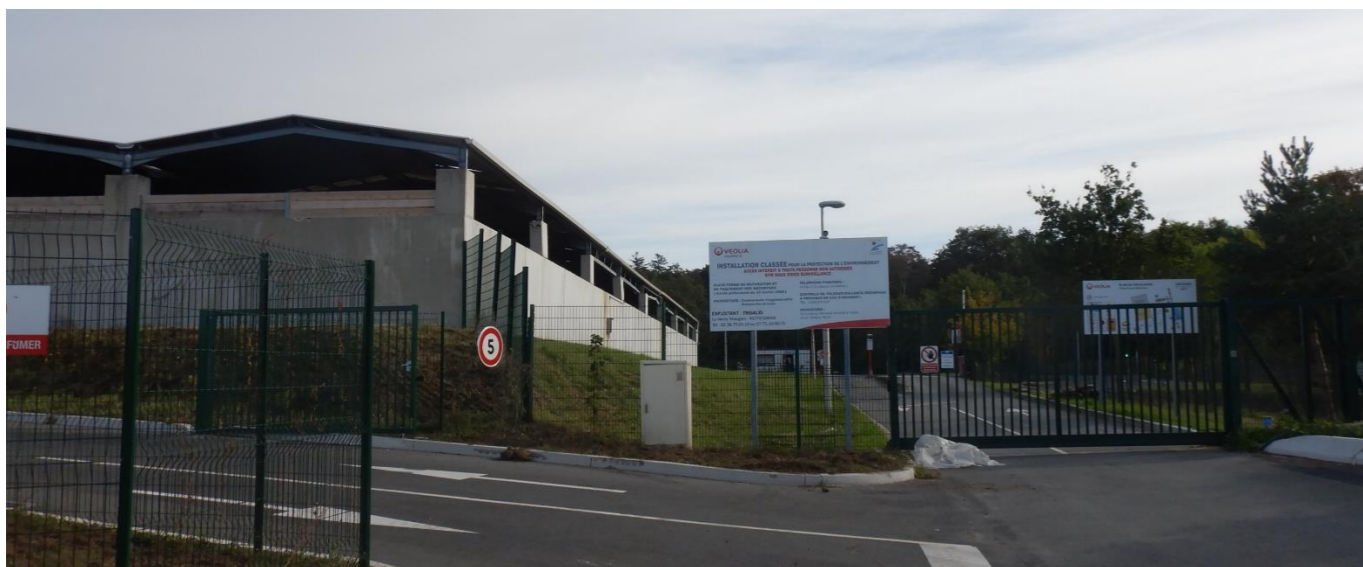
Photo 57 : plateforme de maturation et de traitement de mâchefers TRISALID
