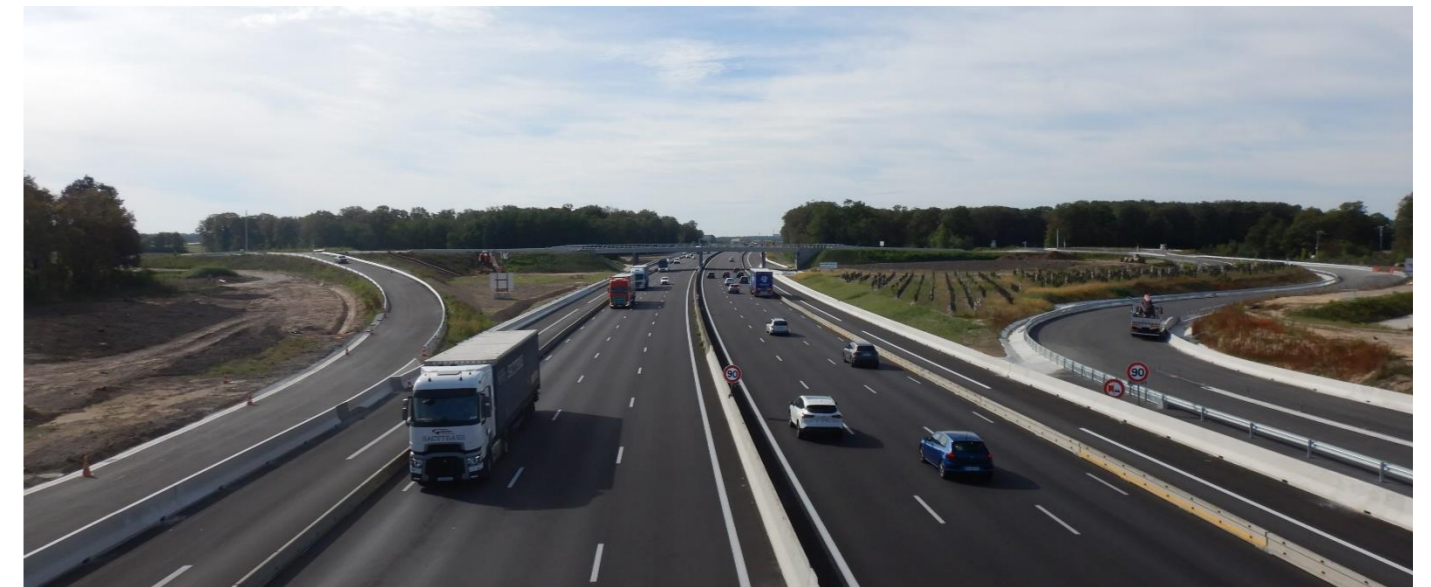
Photo 58 : autoroute A10 en limite nord-ouest de la zone du projet
