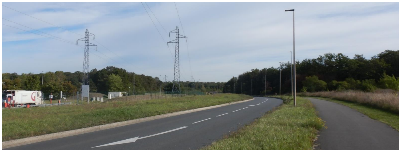
Photo 62 : RD197 au sud-est de l'aire d'étude immédiate
