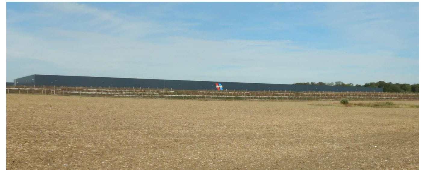
Photo 51 : DERET Logistique depuis la limite sud-est de la zone du projet
